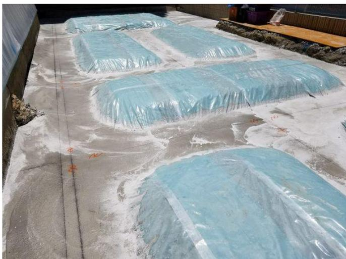
そして、その捨てコンクリートの上に鉄筋や型枠を組むための基準の墨を打ちます。
