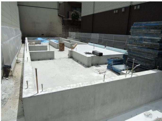
現場に戻り、基礎の養生期間を置いて内部の型枠の撤去♪
