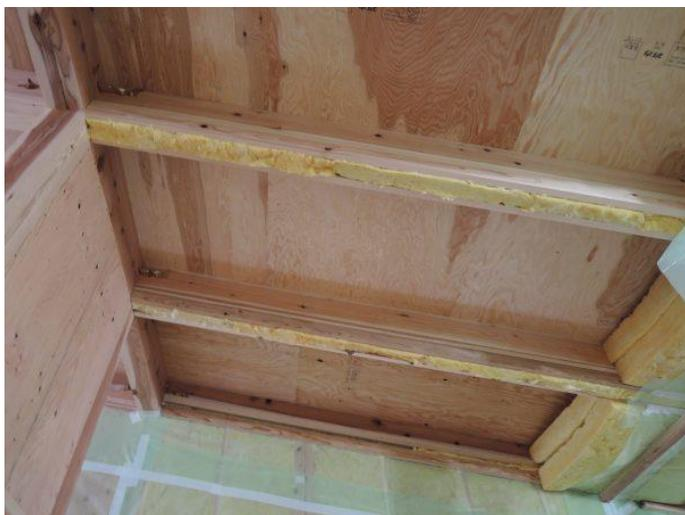
天井の断熱材も引き続き施工してます。
