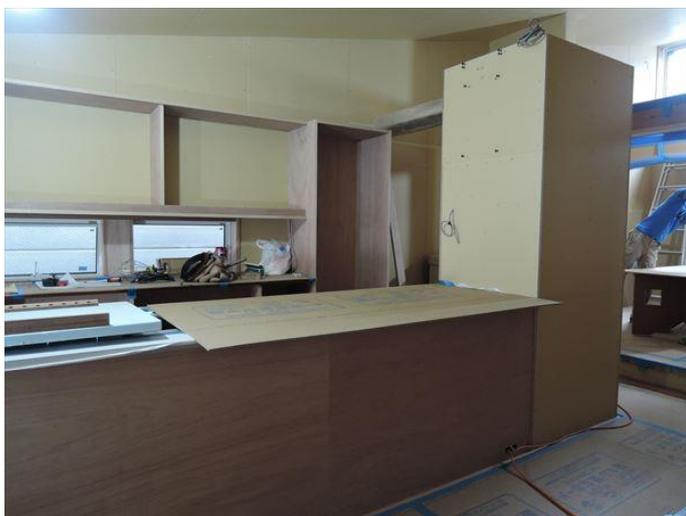
換気扇を仮で付けて、ビスの位置だけ出しビスのみ設置。
