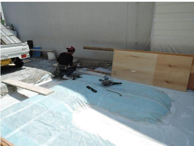
配管が仕込み終わったら引き続き型枠の加工設置。
