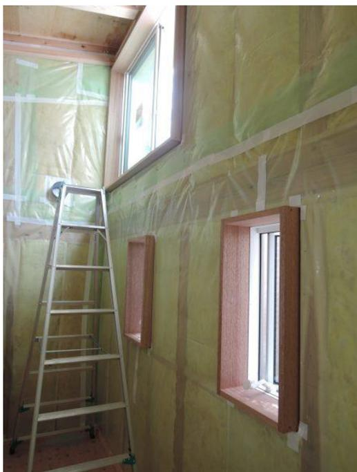
内部の窓枠も取り付けていってます。
