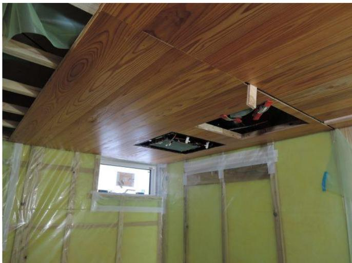
お風呂と洗面の間はガラスで仕切る為、天井の板座は隙間をあけてます。
