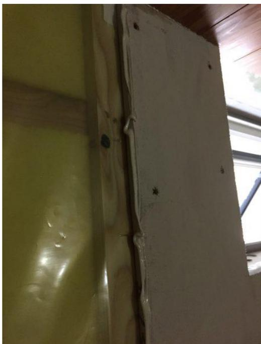
アクアパネルのジョイントには専用のボンドを塗り、硬化する前に表面に出てきたものを取る！！
