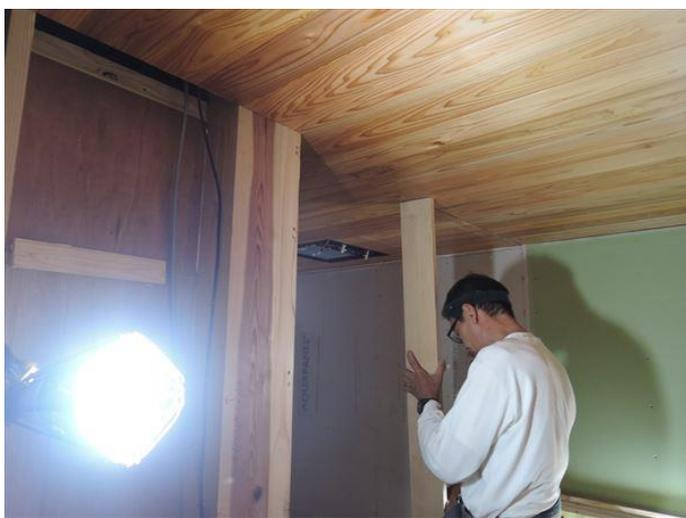
洗面脱衣室と浴室の天井には吉野杉の上小節材に、セラミック塗装の撥水材を塗ってます。
