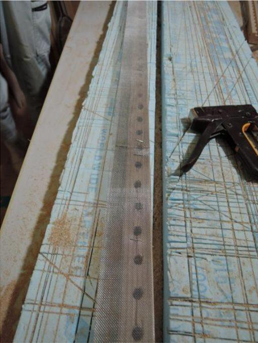
上からゴミが落ちないようにステンレスの網を付けてます。
