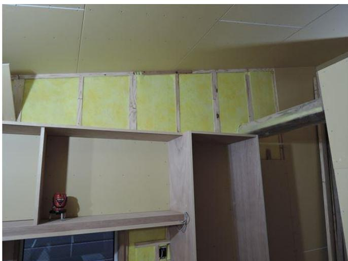
カップボードの下地ができたので、その上の付加断熱施工を。
