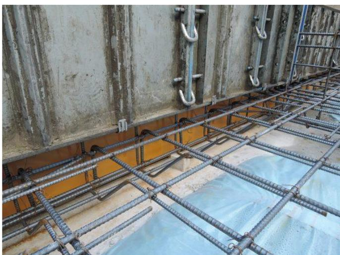
その上に内部のメタル型枠をのせます。
