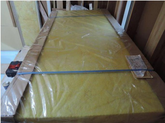
壁体内に断熱材を 120mm入れて、内側に配線胴縁を兼ねた寸三（35mmの材）を打ってその間にこのマグボードと呼ばれる 25mmの断熱材を入れ込みます。
