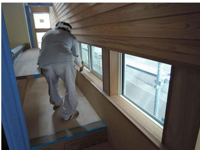
2階の窓枠もクリア塗装♪
