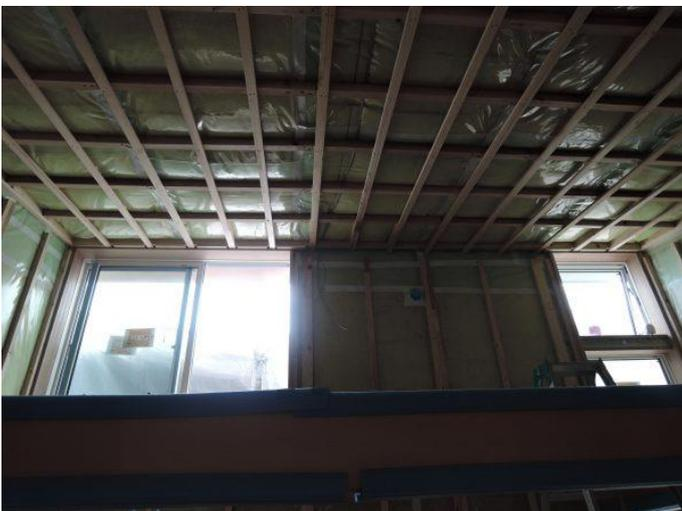
天井の断熱のシートと天井下地の間を通して配線施工。
