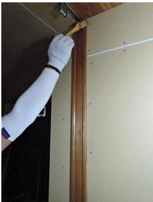
大工工事が終わり、クロス前に枠材のクリア塗装♪
