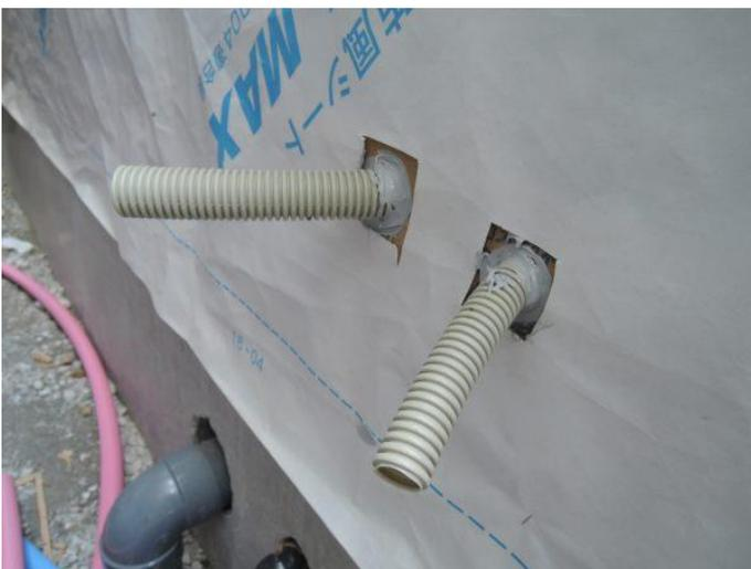
電気配線を出す所も外部の隙間はコーキングで処理。
