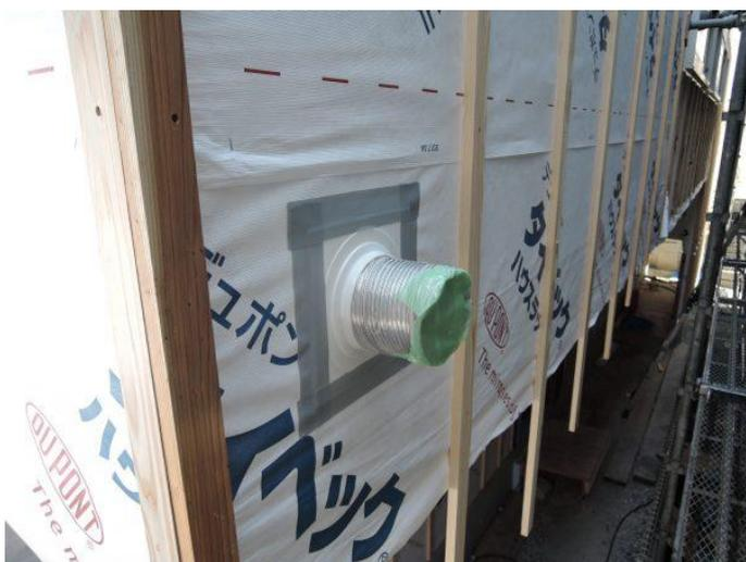
外部の換気扇の配管を回りは内部と同じ日本住環境のドームパッキングで処理。
