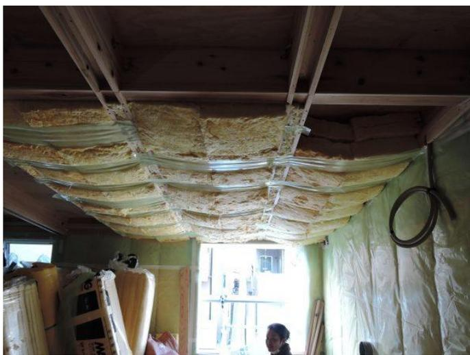
2階の壁の断熱施工も終わり、引き続き天井の断熱材を施工。
