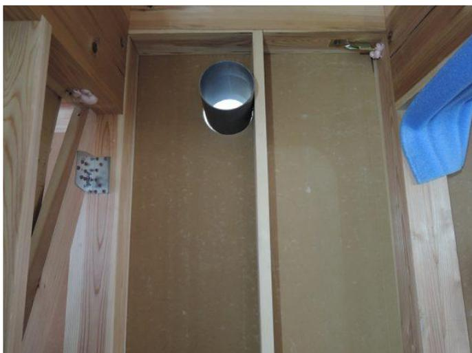
気密欠損にならないように先行して、パイプを入れます。
