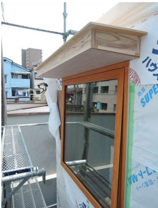
正面に付いた木製サッシは、直接雨がかかりにくくするため、庇と袖壁をつけます。
