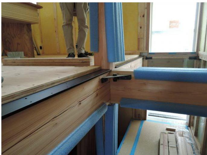
先ほどの吹き抜け部分に特注して黒く焼付塗装された鉄の金物を取りつけてます。
