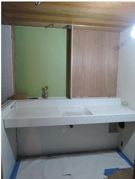
給排水をピンポイントで上げた洗面化粧台の設置。
