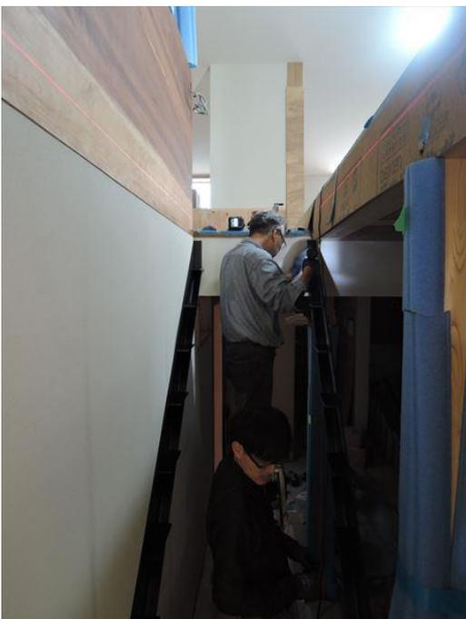
KANAMONO 工房、金城さんが階段の側板を鉄で作ってきてくれて取付を。
