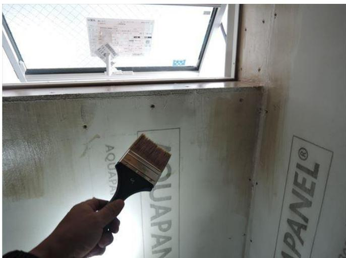
撤去後は、専用の防水塗料を塗っていきます。
