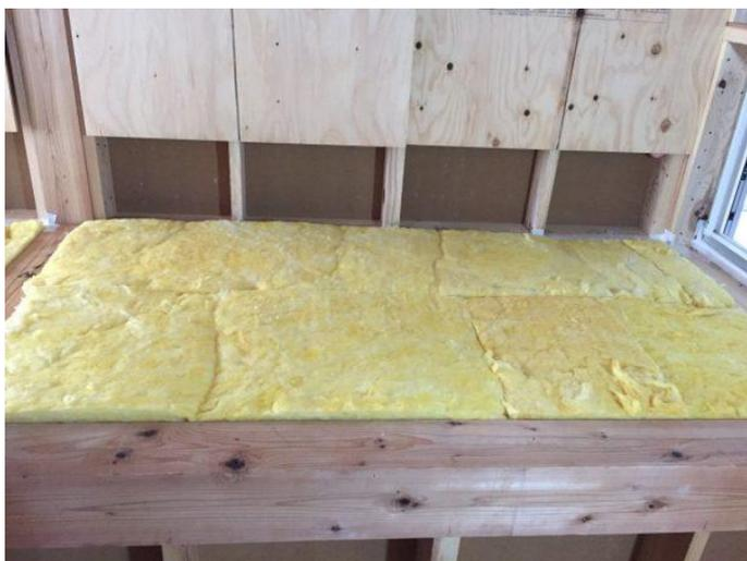
2階の飛び出した部分の床の断熱材入れ。
