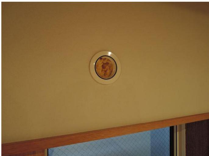
使わないエアコンの穴には余った断熱材を詰め込んで断熱欠損をなるべくなくすようにしてます
