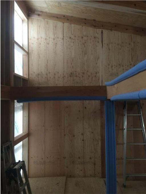
そして、中間検査(金物検査)に向けて内部の耐力壁となる所に合板準備。
