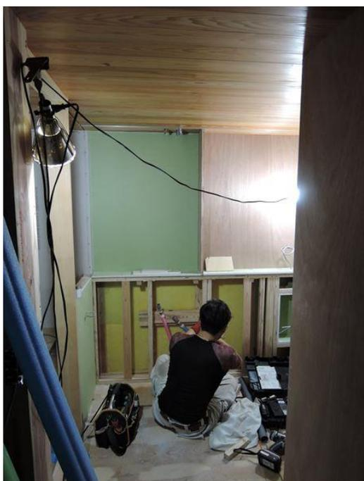
洗面台の下地ができたので、水道屋さんがピンポイントに給水・給湯・排水を仕込んでくれます。
