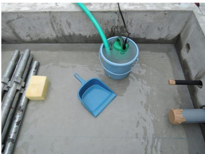
なので、朝一から水中ポンプと塵取りと、スポンジを使って水抜き(\*\_\*;
