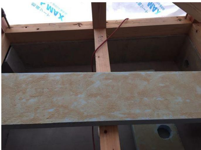
基礎のコンクリート面と断熱材の両方に専用のボンドを塗ります。
