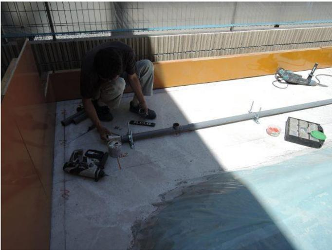
水道排水の指示をした所に、水道屋さんがばっちりの所で配管を設置。
