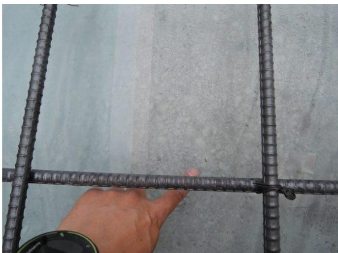
検査の時間中暇なので、鉄筋組みの時に破れた防湿シートの補修を。
