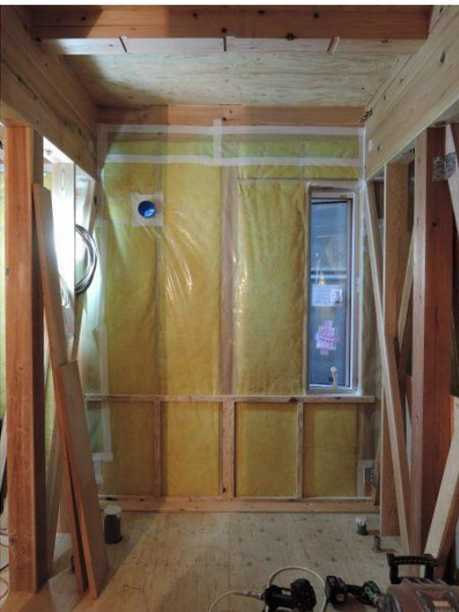
トイレの負荷断熱用寸三（35角の材）を内部に打ち付けていってます。
