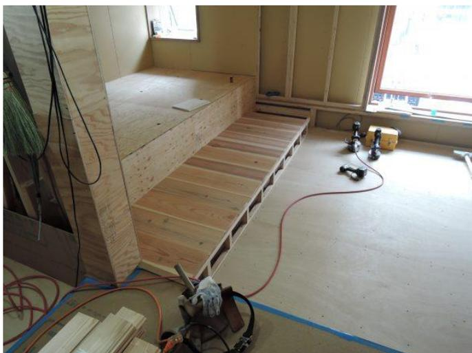
先ほどの木の下地の上に、30mmの床に張るものと同じ吉野杉のフローリングを実(サネ)カットして置いていきます。
