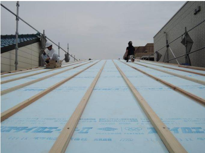
上棟次の日に、屋根の外断熱の仕舞を。内部にも高性能 GW16K120mm×2重にする予定なので屋根の熱はかなり緩和されるのではないのでしょうか？
