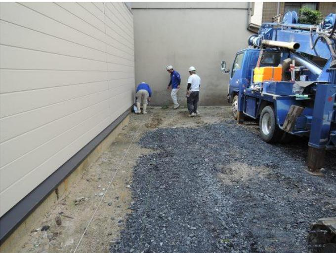
敷地境界のポイントから距離を測り、碎石パイルを打ち込む位置をしるししていきます。
