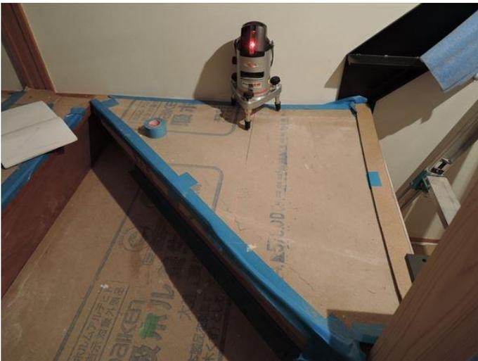
加工した段板を、仮で設置。
