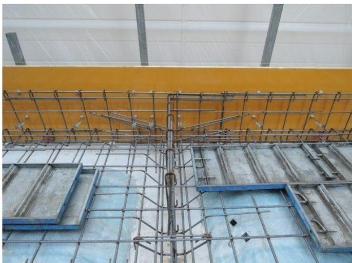
外周部の枠型枠から、セパ穴を使って金物を出します。
