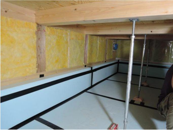
1階寝室下にある収納庫の外壁側の断熱材も入れていってます。
