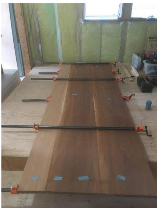
作業場に置いてるポニークランプ（この大きな木を挟んでる鉄の材）を現場にもっていき現場幅はぎ作業！
