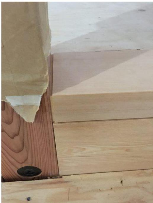
柱と下の梁は突き付けとせず、3mmほどあけてます。
