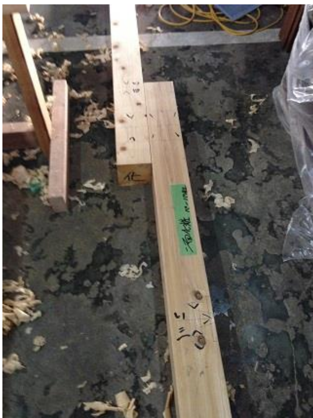
土台に墨付けをしています。
