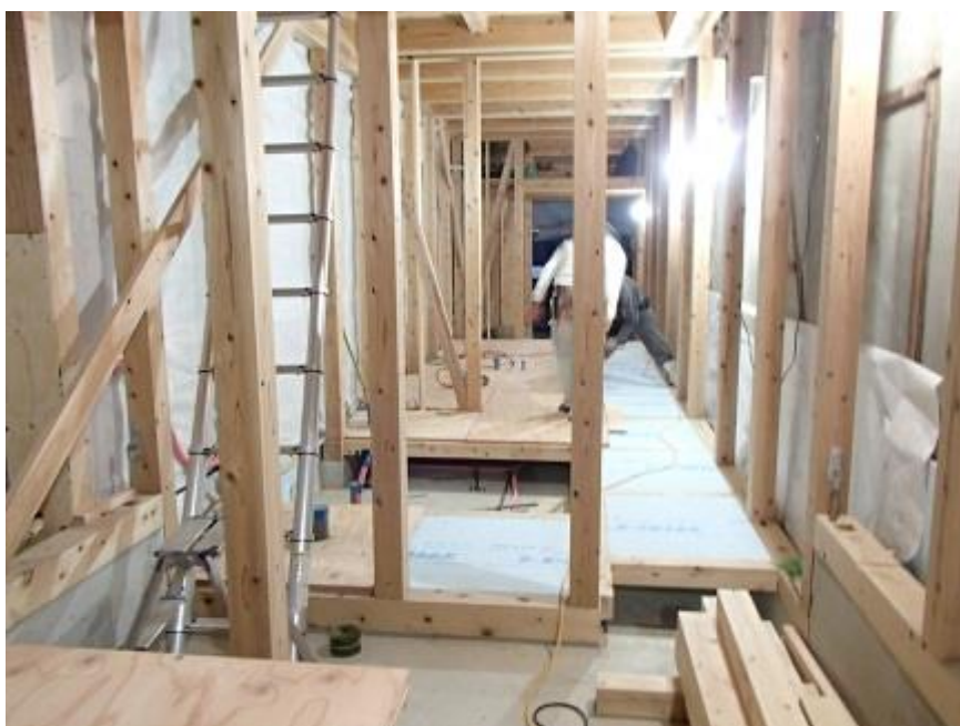
床下にも断熱材を施工。
