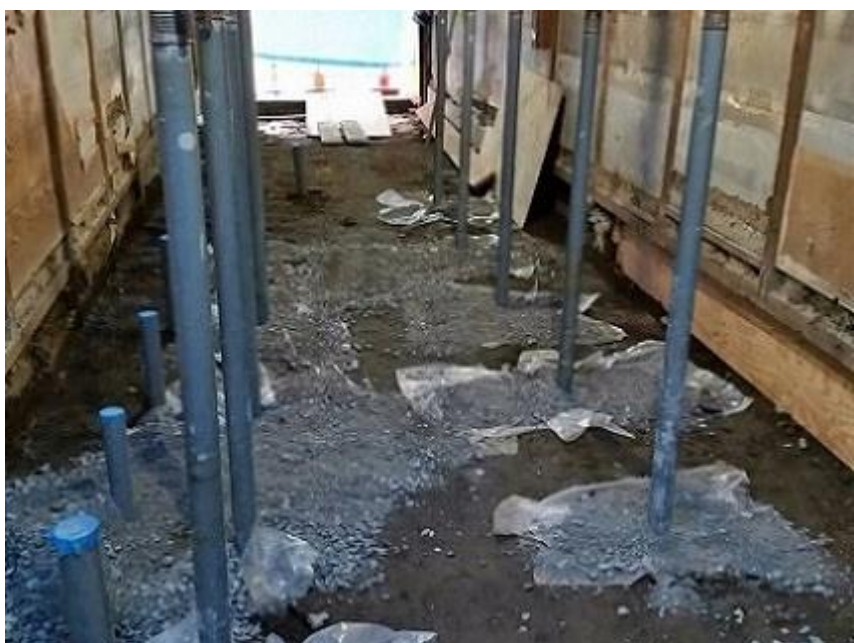
引き続き、碎石敷き。
