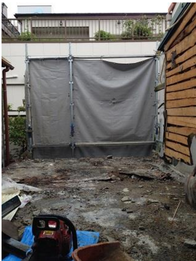
バルコニーの下地なども解体終わり！！
